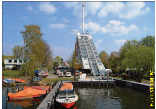
Gesamtanlage des Siegfried-John-Hauses von der Wasserseite
