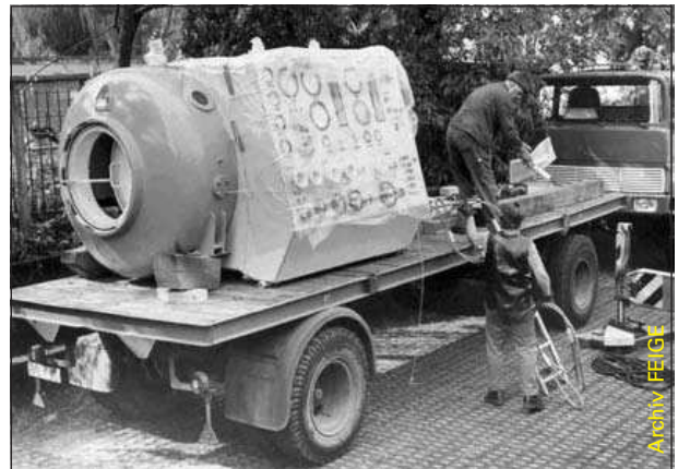
Die Hauptkammer wird zur Montage vorbereitet
