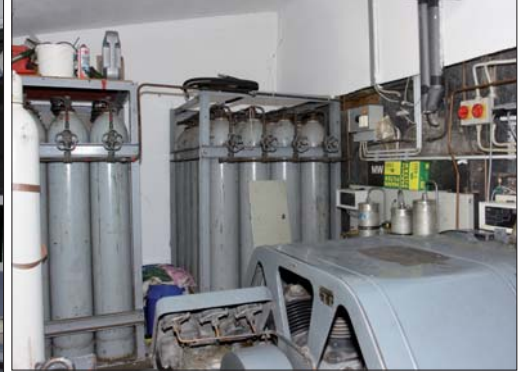
Hohe Sicherheit: Um größere Tauchtiefen zu simulieren, lässt sich der Luftbereich oberhalb des Wassers mit Druckluft beaufschlagen. Hier sind die Druckluft-Flaschenbatterien zu sehen. Sie enthalten so viel Druckluft, dass die Taucher auch bei einem Ausfall aller Systeme (Kompressoren) regelgerecht mit den entsprechenden Dekompressionszeiten auftauchen können.
